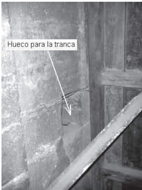
Fig. 2. Cierre interno de la puerta del torreón (9)
