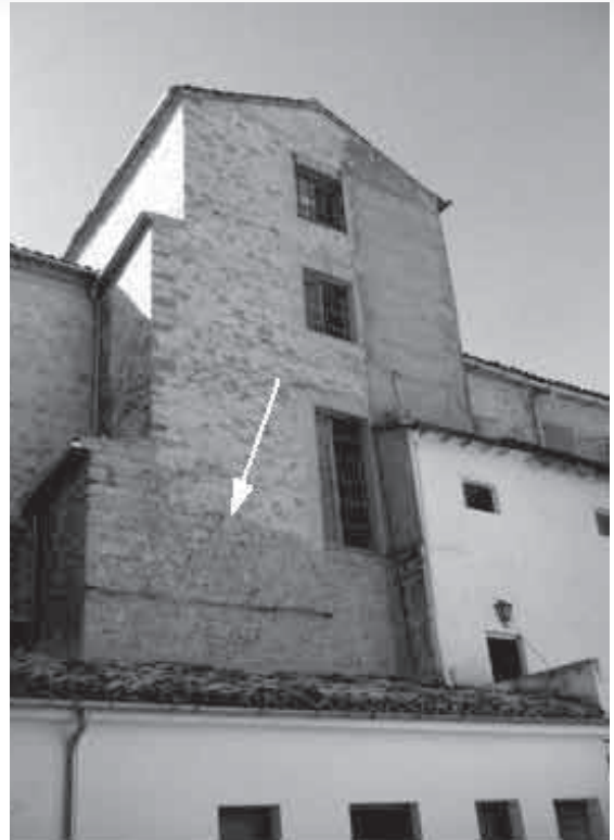
Fig. 4. Torreón 12. Sólo desde la línea de discontinuidad hacia abajo pertenece al torreón original.
